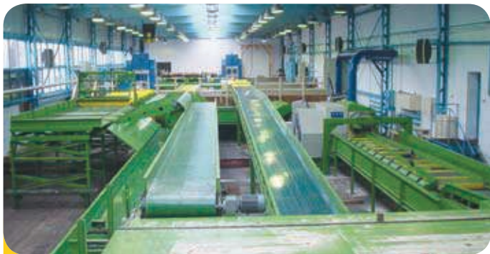
Mechanizacja hali traków – COMPLEX, Dziemiany
